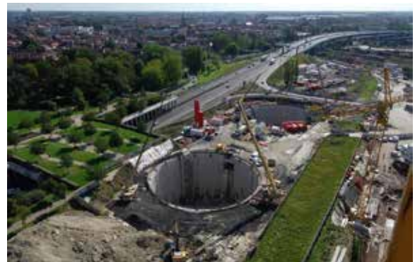
Lille - Bassin d'orage de Chaude - Rivière
